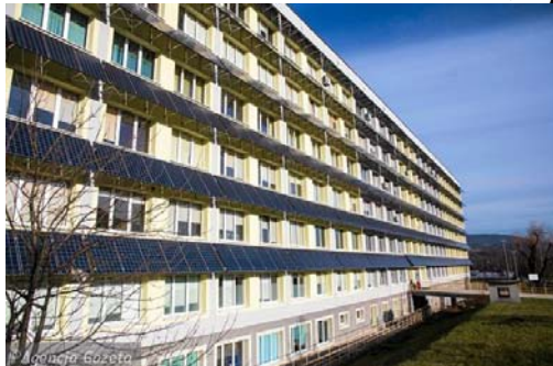
Obr. 2: Budova nemocnice Sucha Beskidzka po osazení fotovoltaickými markýzami
