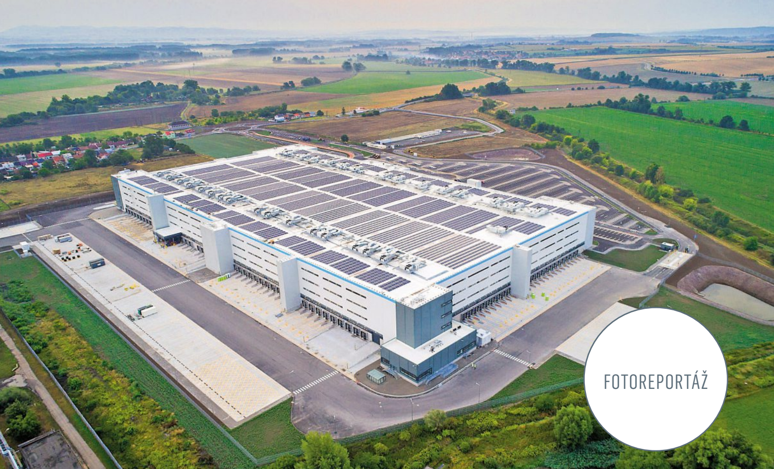
Celkový pohled na areál Panattoni Parku Kojetín.
