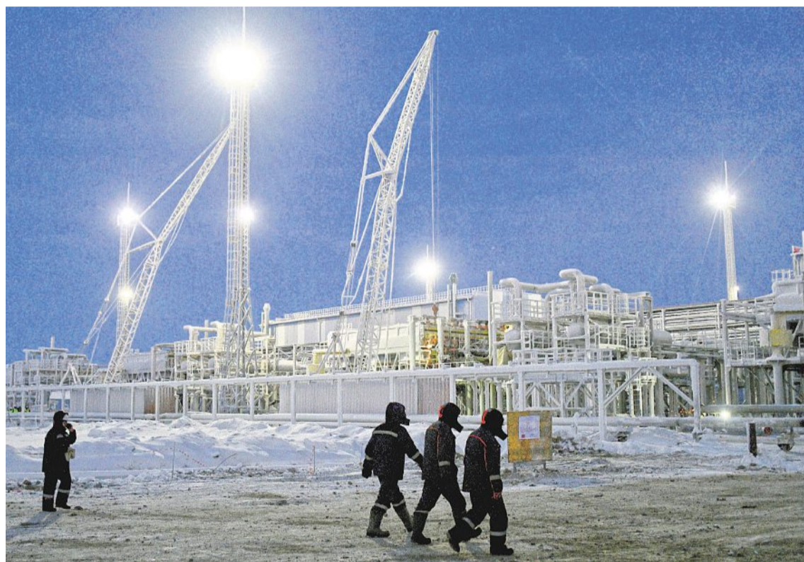
Arctic LNG-2. Komplex na zkapalňování zemního plynu bude mít tři jednotky, každou o kapacitě 6,5 milionu tun LNG ročně. Zatím je dokončen z necelé třetiny. Foto: Profimedia
