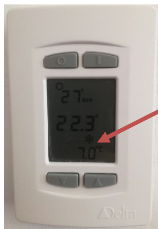
Obr. 2 - Vizualizace stavu otevření okna (7.0°C)
