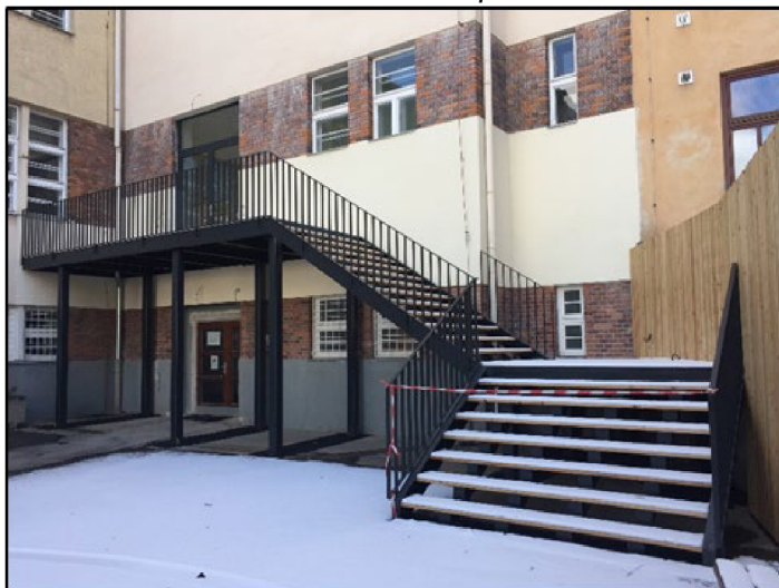
Lávka a schodiště těsně po dokončení
