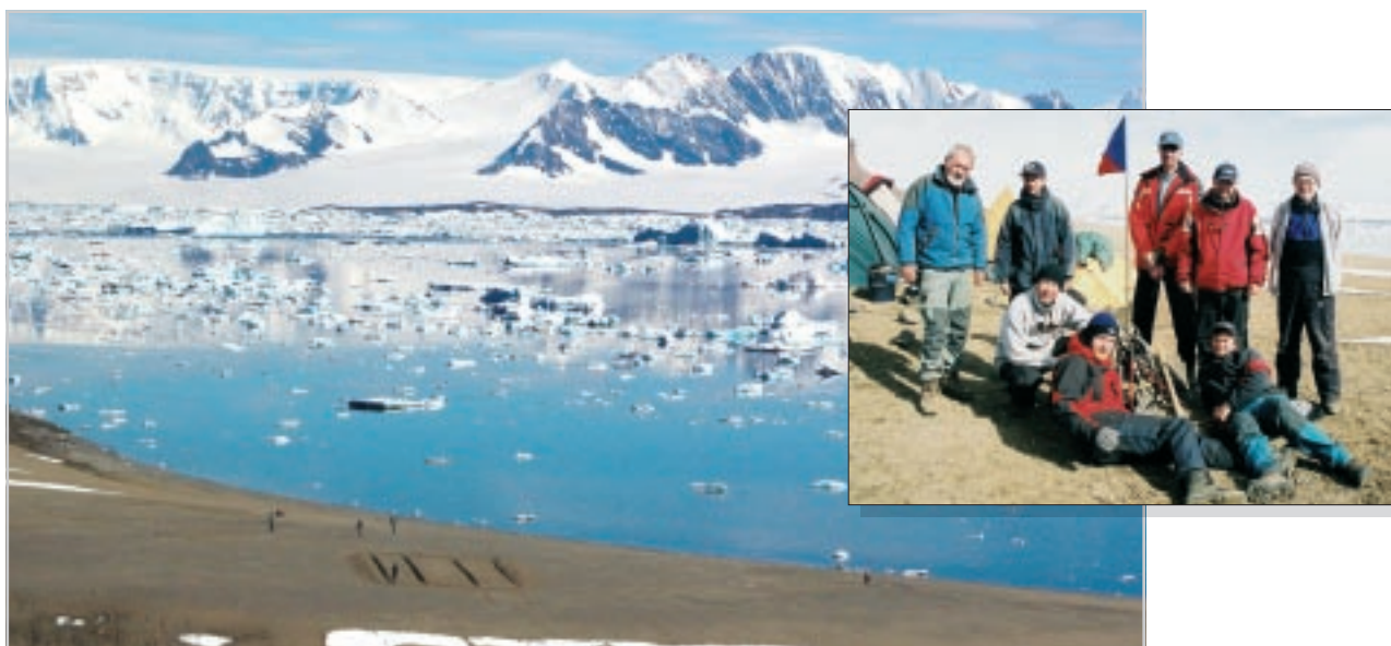
Základy stavby české vědecké stanice v Antarktidě na ostrově Jamese Rosse – počátek roku 2005 (Masarykovu univerzitu zastupoval duchovní otec projektu Pavel Prošek)
