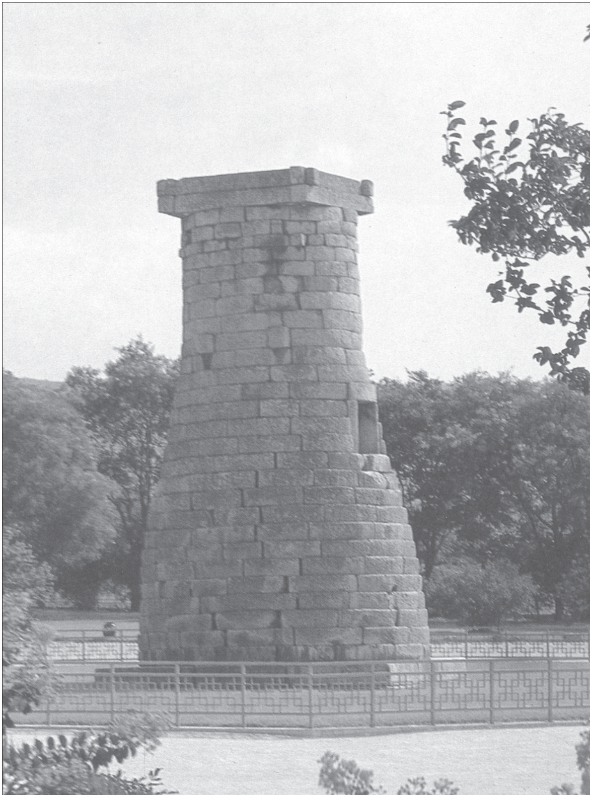
22 Anonym, Observatoř Čchömsöngdä , postavena mezi léty 632–647, kámen, výška 900 cm. Kjöngdžu, Korejská republika. Čchömsöngdä je jednou z nejranějších kamenných observatoří na Dálném východě a její architektura zřejmě odráží astronomická a kalendářní data: dvanáct základních kamenů představuje počet měsíců v roce, třicet kamenů dny v měsíci a celkový počet 366 kamenných kvádrů stavby znamená dny v roce.
