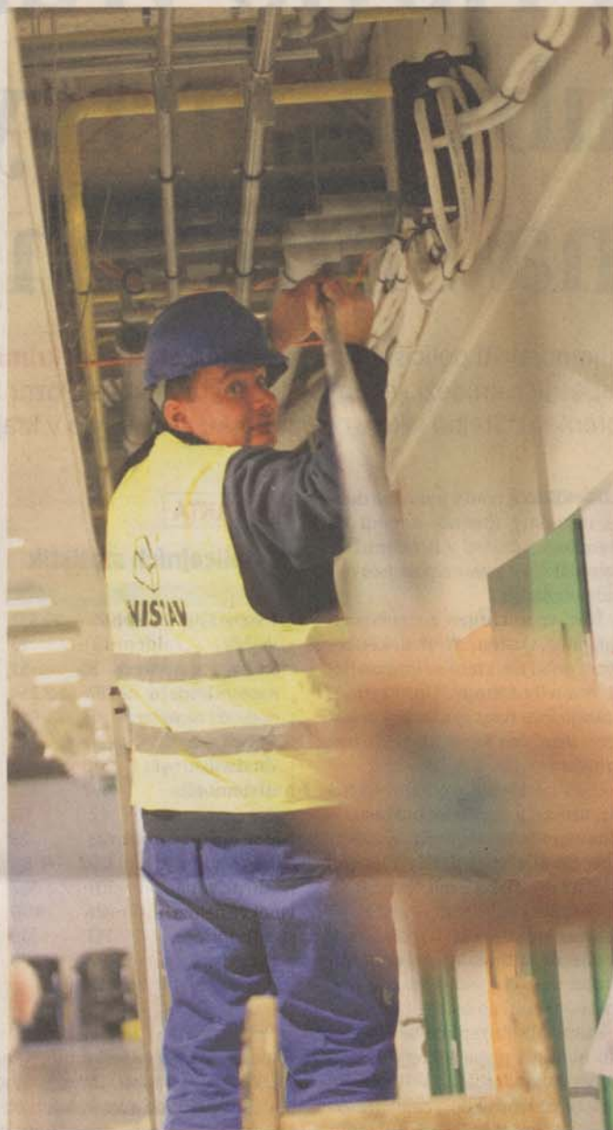
Za nerez V univerzitním kampusu v Brně vyměňují řemeslníci vadné pozinkované vodovodní potrubí.
