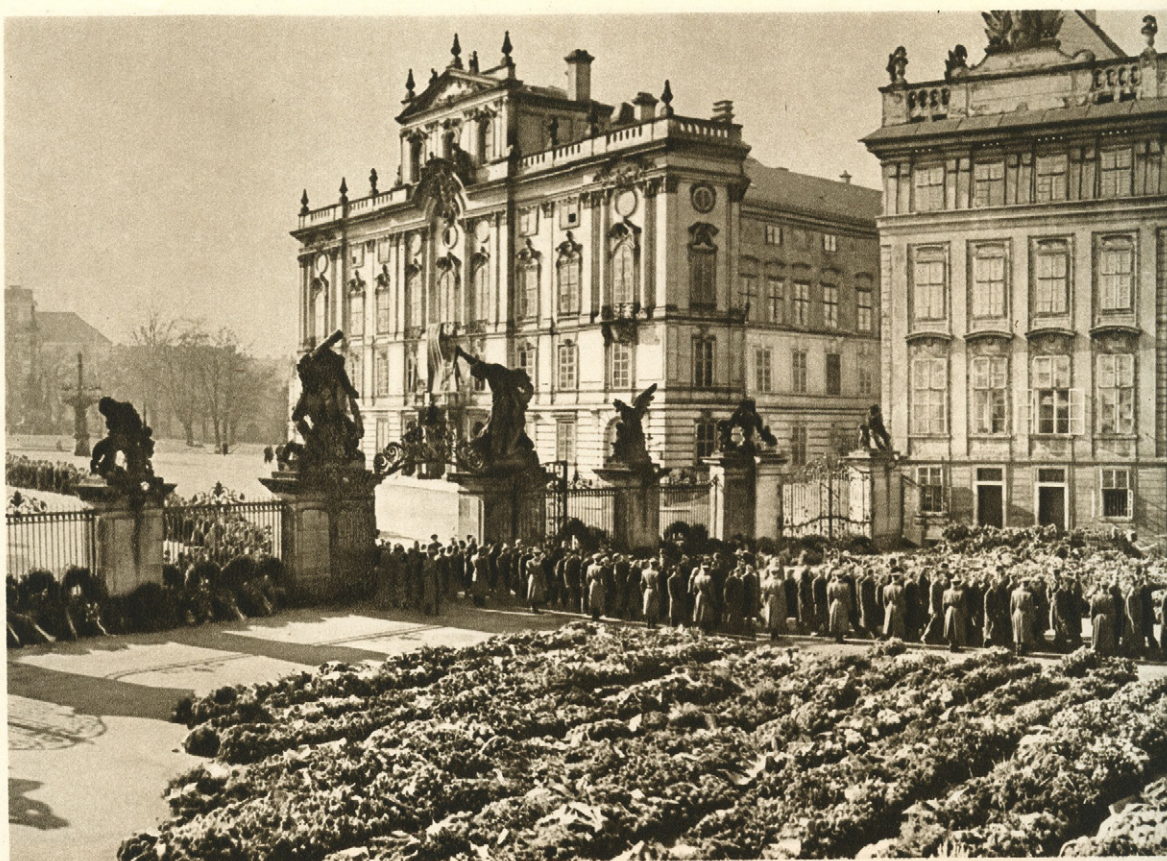
NEKONEČNÉ ZÁSTUPY PRACUJÍCÍCH SE PŘICHÁZEJÍ ROZLOUČIT SE SVÝM UČITELEM A VŮDCEM.
