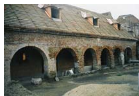
Stav konstrukcí dvorního traktu po sanaci
