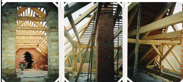
Zastřešení objektu novým krovem
