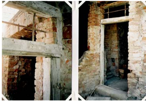
Stav obnažených konstrukcí v prostoru dveřních otvorů
