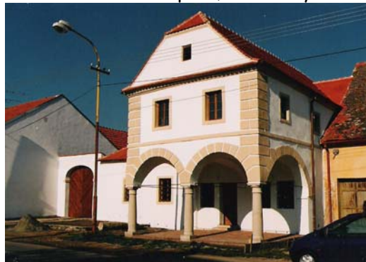
Stav objektu po rekonstrukci
