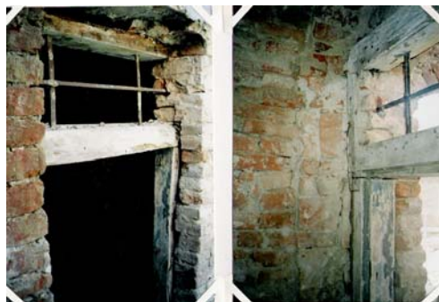
Stav obnažených konstrukcí, ostění dveřních otvorů
