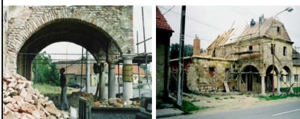
Znovupostavení podloubí v přízemí návěsní části
