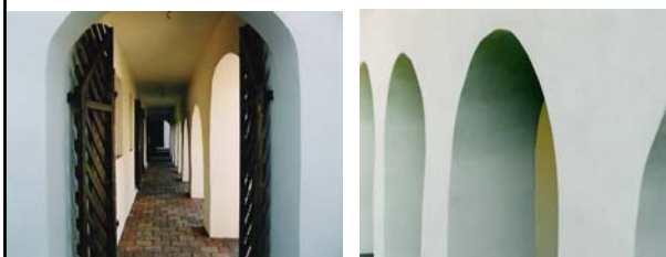
Stav konstrukcí arkády dvorního traktu po sanaci
