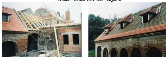
Provádění nového zastřešení objektu
