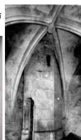
Klenba a točité schodiště v břitové věži ze 14.stol.
