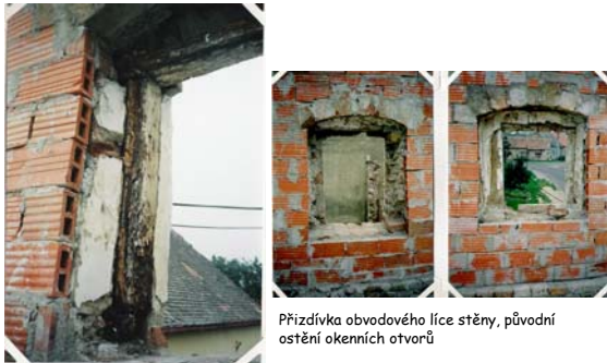
Stav ostění okenních otvorů
