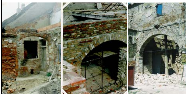
Stav obnažených konstrukcí
