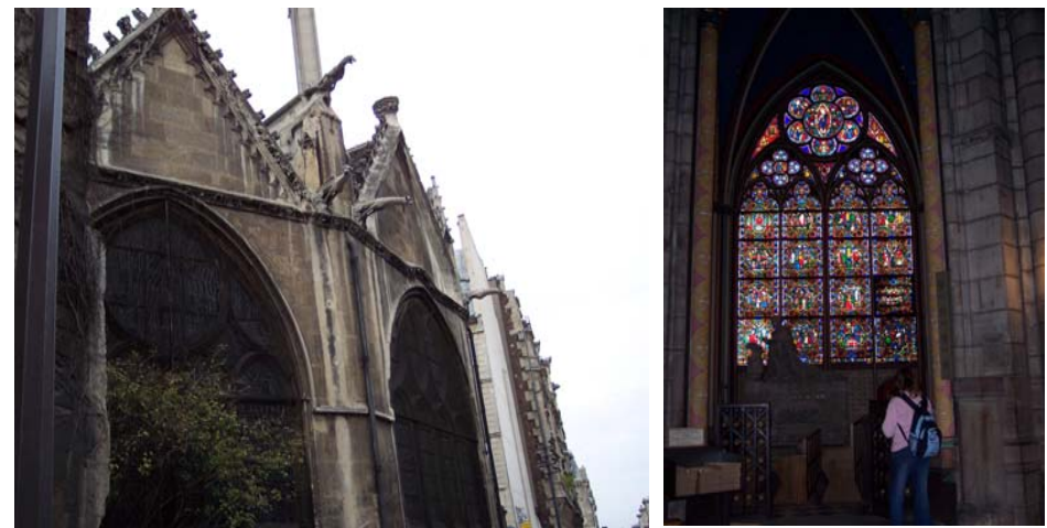
Opěrný systém a vitrážové okno
