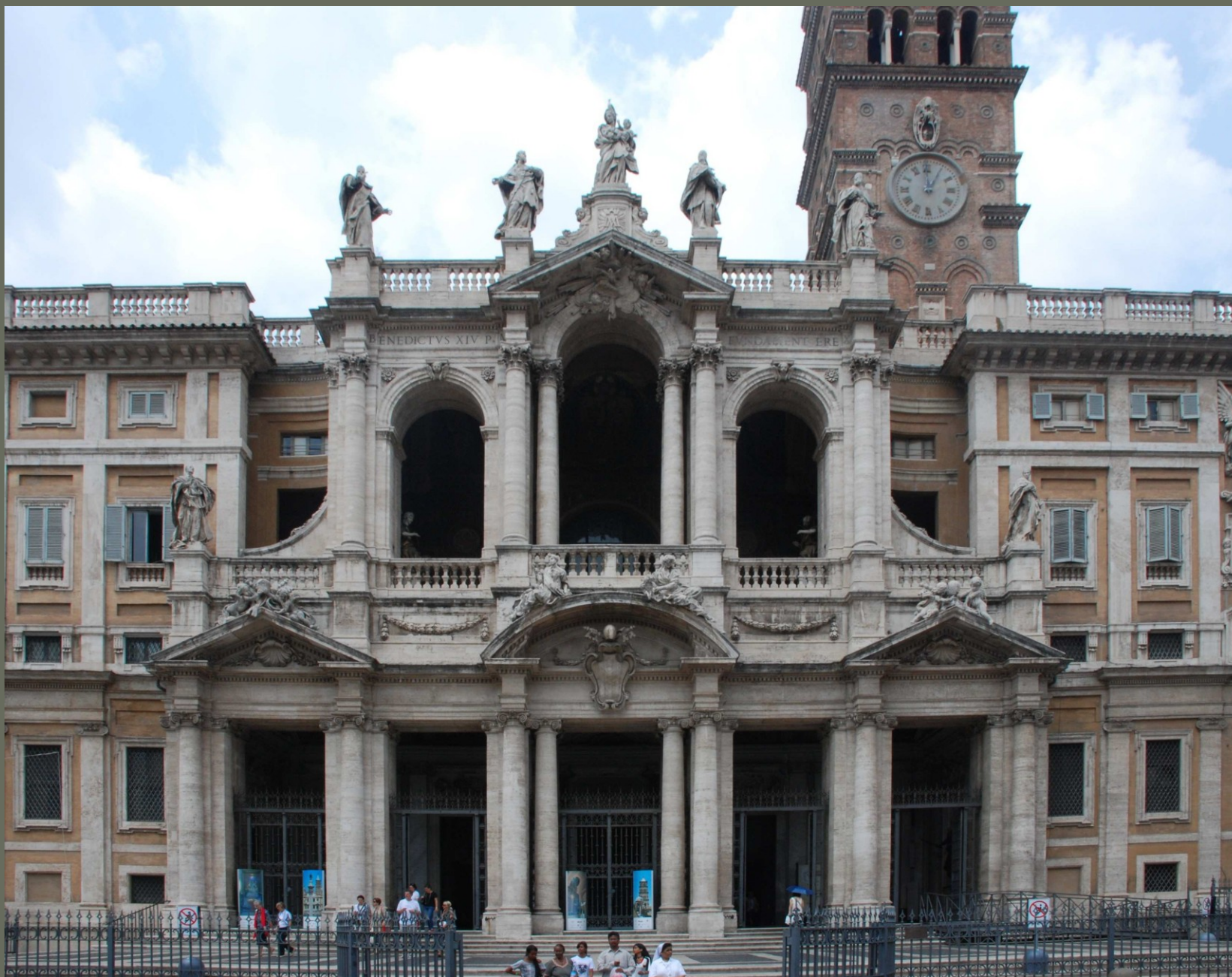
Řím, SM Maggiore, hlavní průčelí, Ferdinando Fuga, 1740
