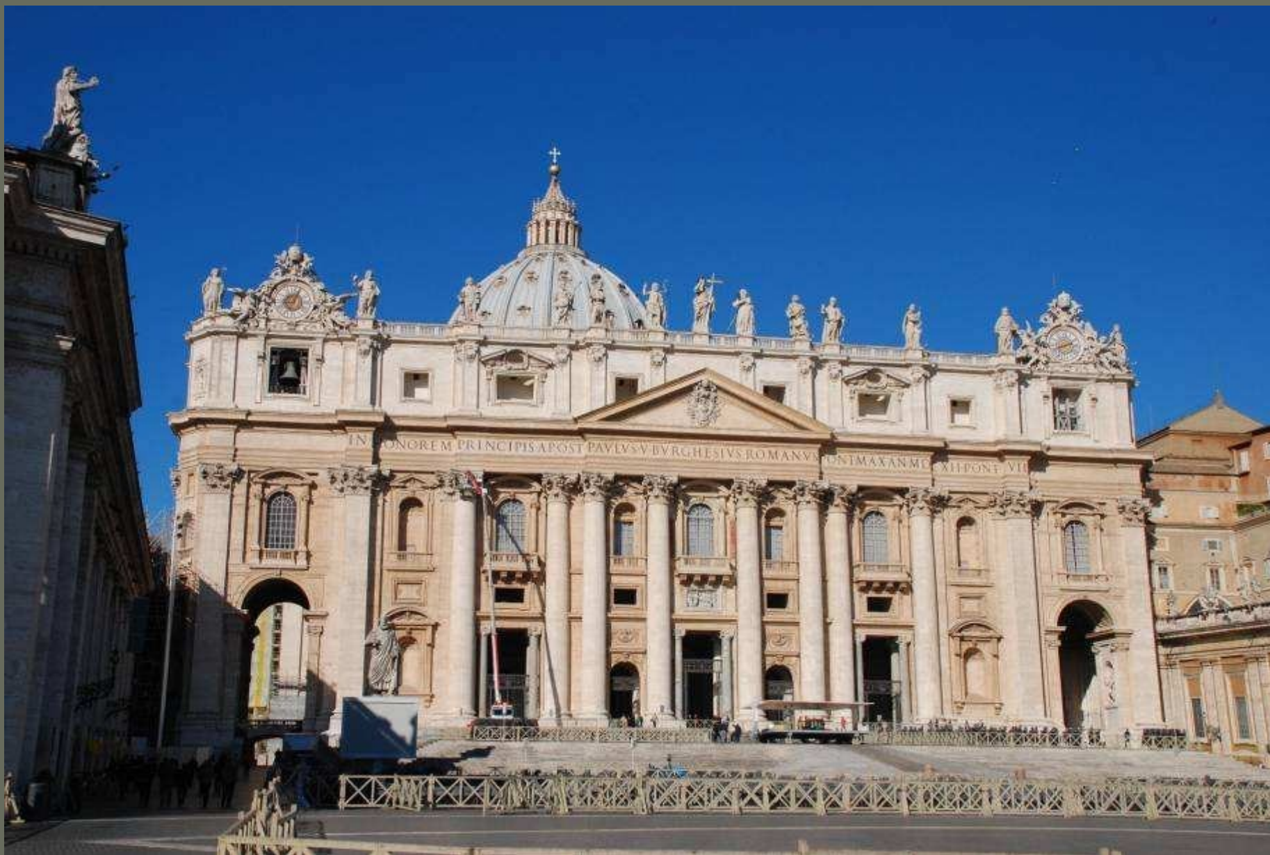
Carlo Maderno, Řím, chrám sv. Petra, průčelí, 1606-26
