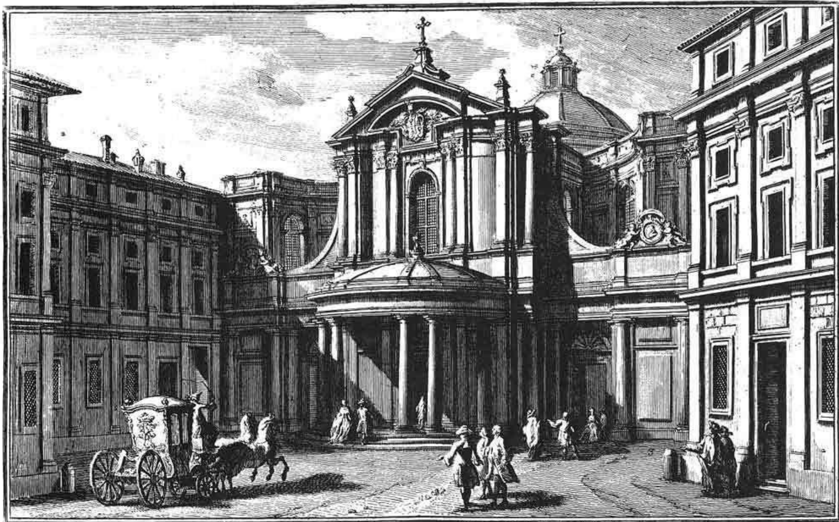
G. Vico - Monastero dei Canonici Lateranensi, e Chiesa di S. Maria della Pace la Porta del Monastero, e Abitazioni, che formano teatro alla Piazza della Chiesa, Ingresso al Corto dei Preti Tedeschi, che officiano la Chi. di S. Maria dell'Anima. 1721
