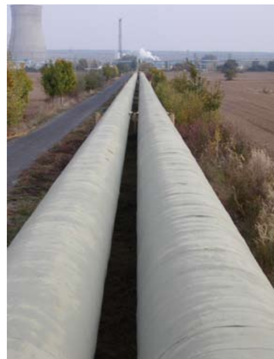
K největším teplárenským dílům v Evropě i na světě patří přes 30 km dlouhý mělnický napáječ, který zásobuje teplem z elektrárny pravobřežní část Prahy. Napáječ je významným příspěvkem společností Energotrans a Pražská teplárenská k ozdravení ovzduší v hlavní městě.
