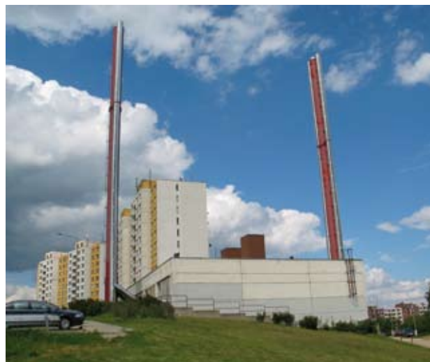
Paroplýnový cyklus Červený mlýn Tepláren Brno je příkladem moderního zdroje s dvoupalivovým systémem zemní plyn/topný olej a velkým akumulátorem tepla.
