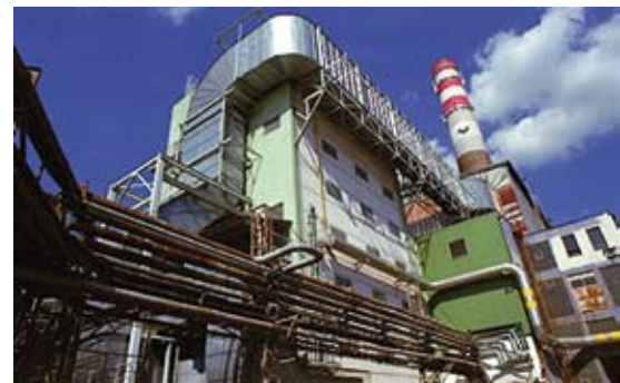
Paroplýnový cyklus Červený mlýn Tepláren Brno je příkladem moderního zdroje s dvoupalivovým systémem zemní plyn/topný olej a velkým akumulátorem tepla.
