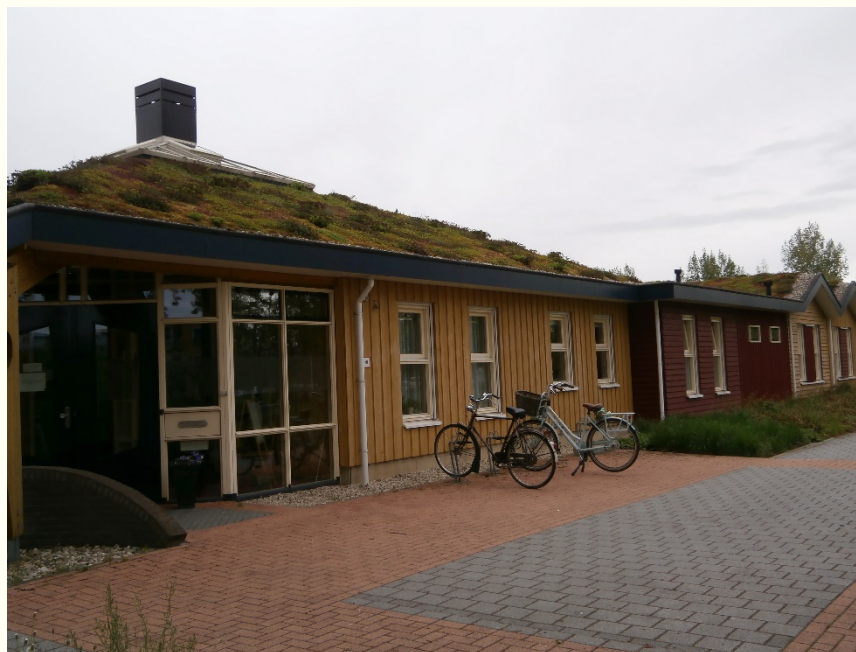
Skupina nadšenců naplánovala a realizovala udržitelnou obytnou čtvrť EVA-Lanxmeer (Nizozemí). Foto: JČ
