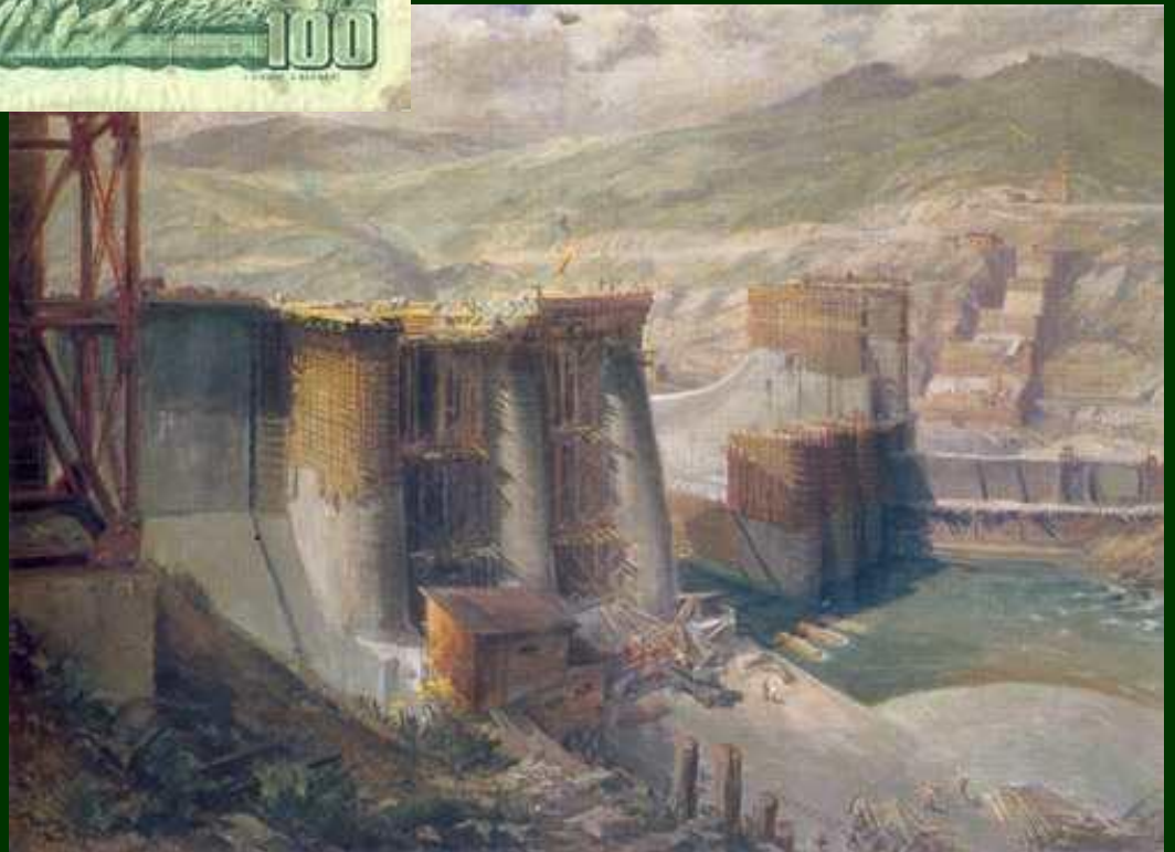
Eduard Světlík: Stavba Oravské přehrady od betonárny, 1952
