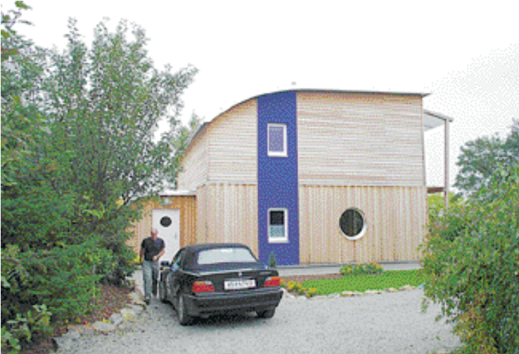
Nízkoenergetický dům v Dolním Rakousku, kompaktní stavba a velkorysá otevření k jihu. Na dolním obrázku pohled na stejný dům od západu
