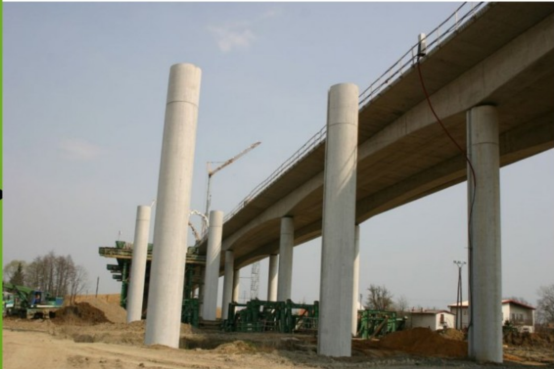
Stavba 4705, estakáda v Hladkých Živicích. Směr Ostrava. zdroj:www.ceskedalnice.cz
