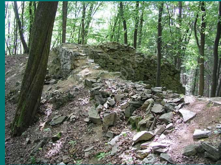
Zbytky kaple a jižní zdi, zdroj: www.hrady.cz
