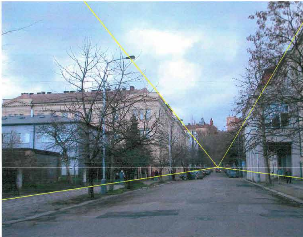
Obr. 12: Pohled ulicí Albertov od ul. Na Slupi směrem ke Karlovu. ŽLUTA: Vyznačení uliční čáry, kterou vy- fronta objektů uskupených v ortogonální zástavbě. Za povšimnutí stojí též honosné dimenze historických un- objektů.
