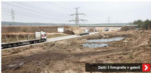
Stavba úseku dálnice D3 Ševětín - Borek | foto: Marek Podhora, MAFRA
