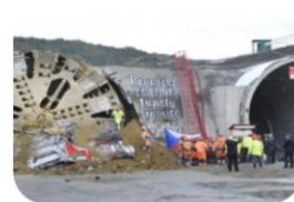
Hloubení jam a ražení tunelů
