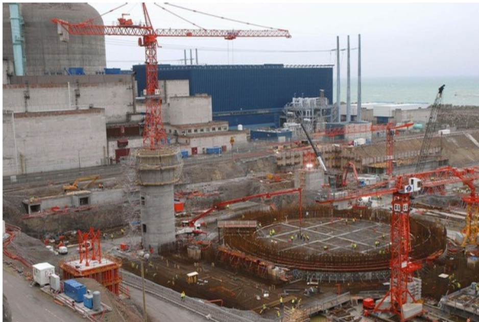
Staveniště nového reaktoru EPR ve francouzském Flamanville
