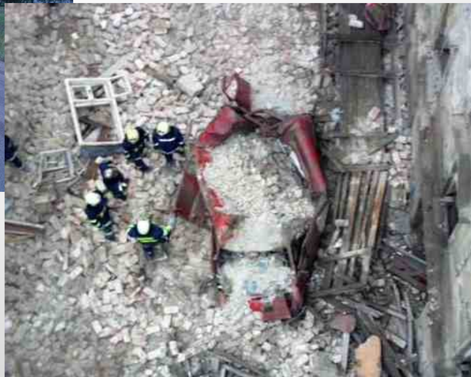
Obr. 10 Zřícení domu Brno 2002
