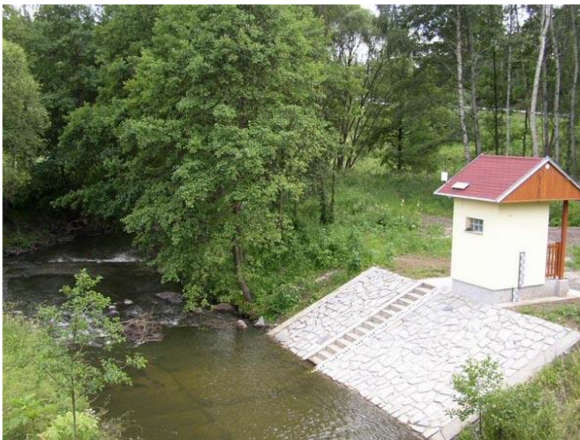
Obr. 9.4 Vodoměrná stanice, zdroj: hydro.upol.cz
