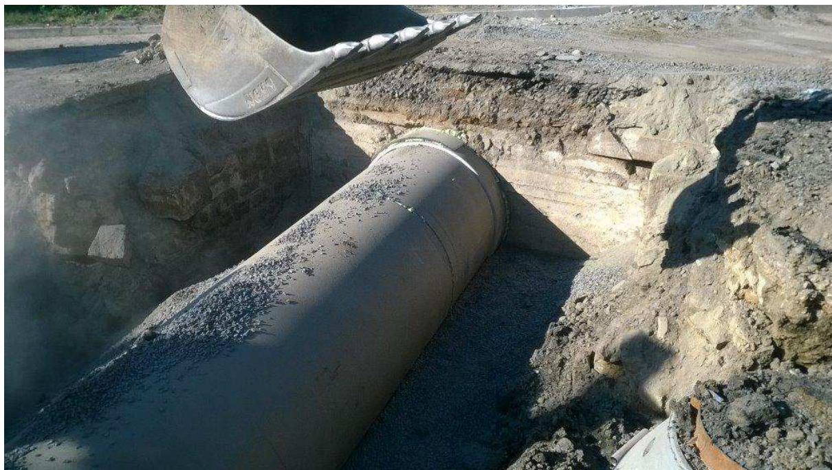
Obrázek 3 Budování kanalizace v obci.
