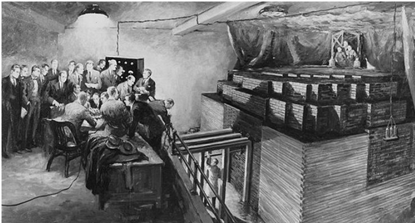
Atmosféra historického okamžiku v Chacagu. Muži vzadu nad reaktorem drží kanystry s roztokem kadmia pro případ nouzového odstavení reaktoru. |
