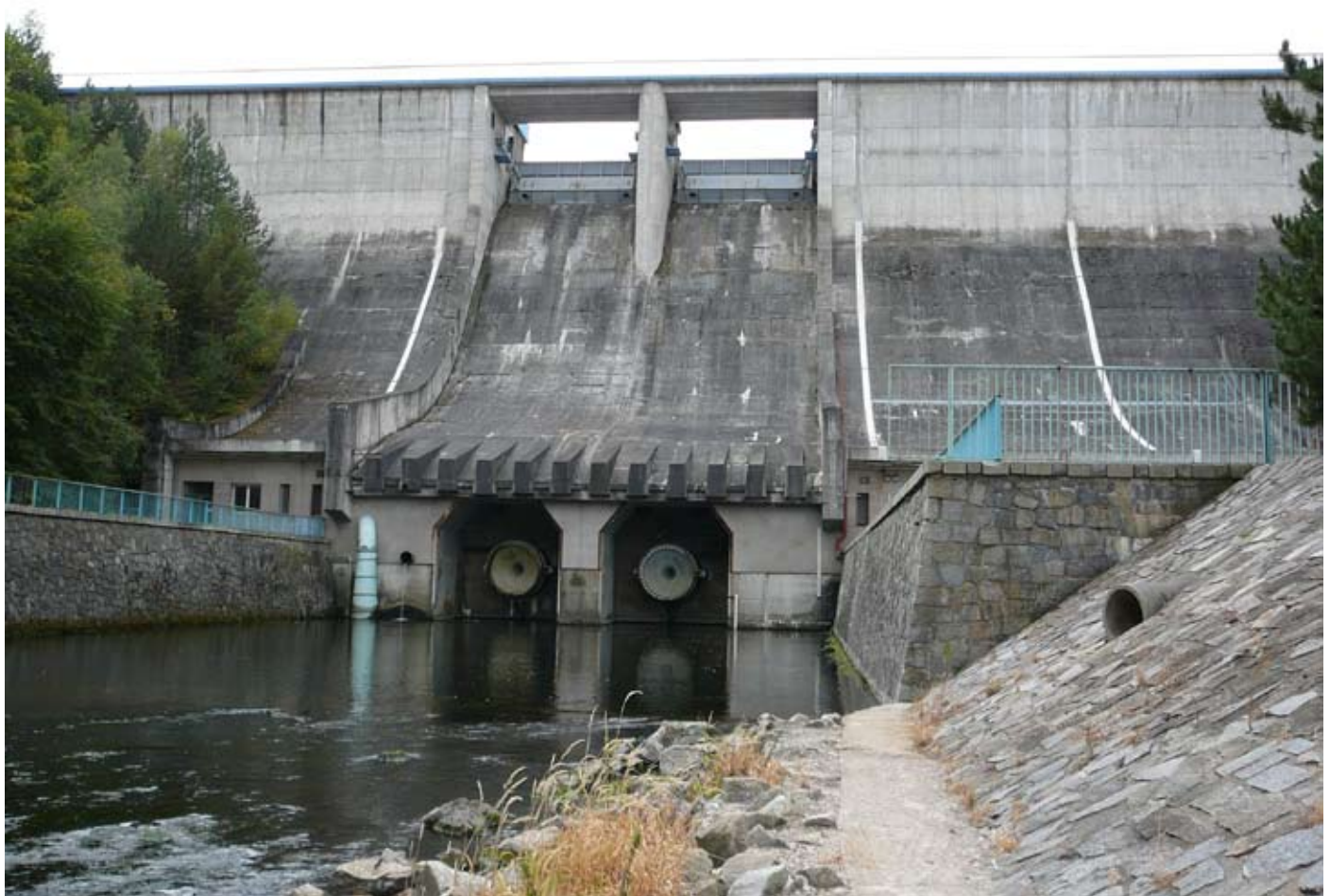
Obr. 93 Vodní elektrárna Dalešice.
