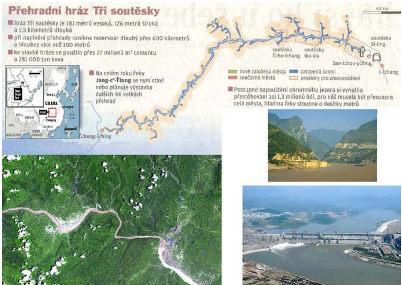
Obr. 122 Přehradní hráz Tři soutěsky na řece Jang c' Tiang v Číně.
