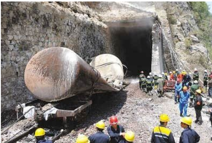
Vagón nákladního vlaku vytaženého ze zříceného tunelu v Číně, zdroj: www.china.org.cn
