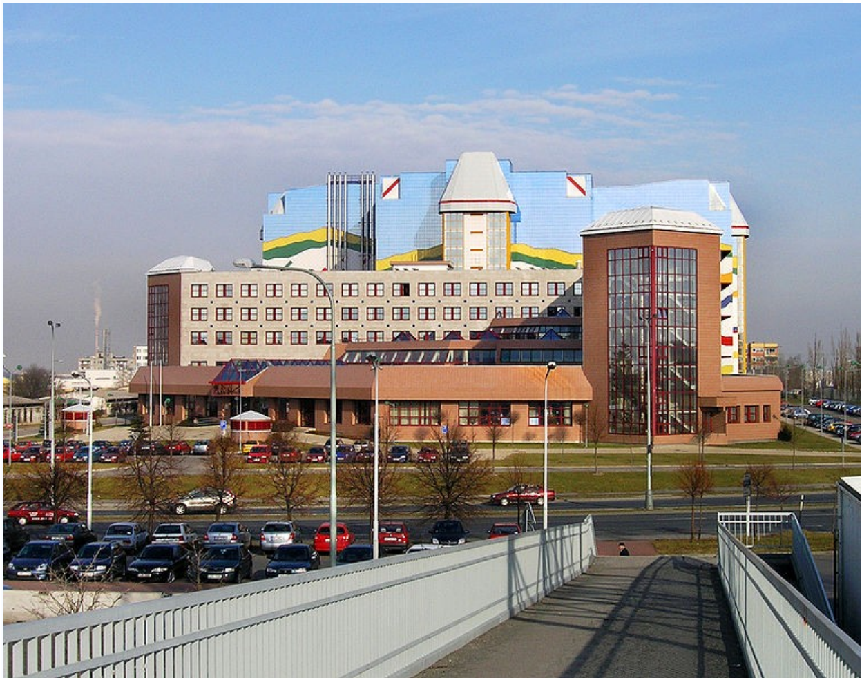
Budova Národního archivu v Praze na Chodovci
