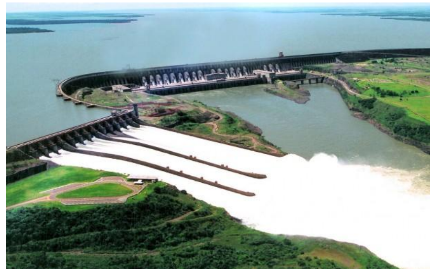
Hydroelektrárna Belo Monte na řece Xingu
