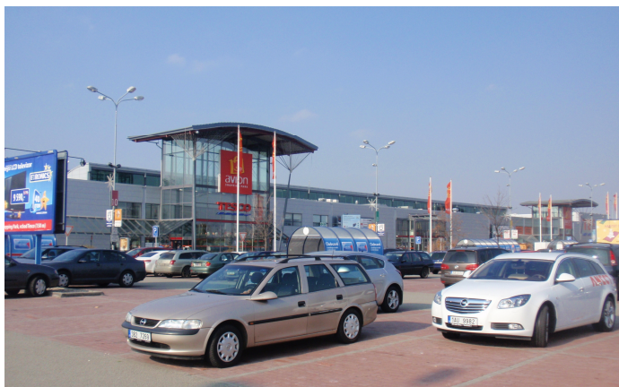
AVION Shopping park Brno. Autor fotografie: Libor Lněnička
