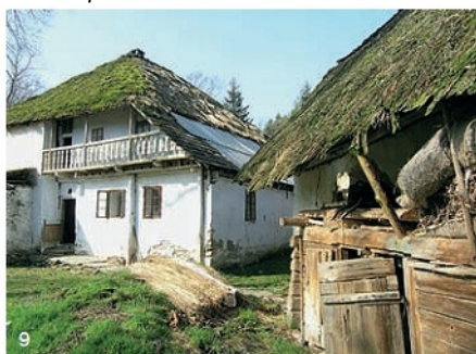
9 Hoslovice (Strakonice) - před obnovou
