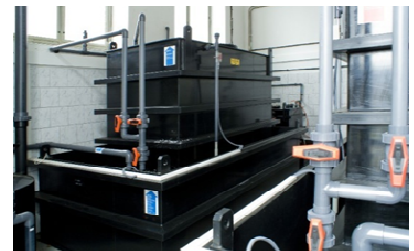
Příprava oxidu chloričitého. Zdroj: www.vodospol.cz
