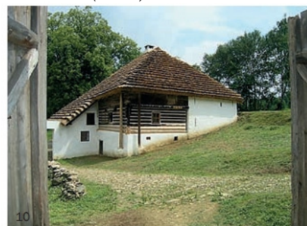
10 Hoslovice (Strakonice) - po obnově
