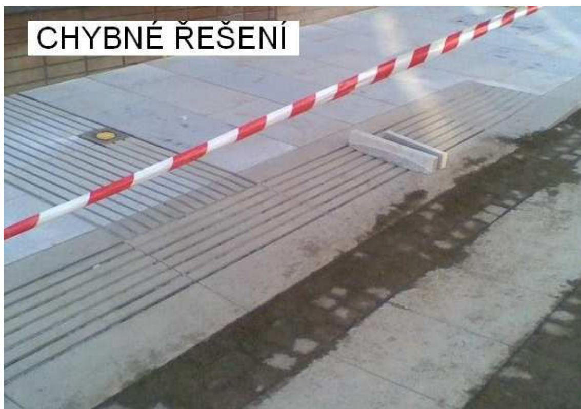
I.67) Havlíčkův Brod
