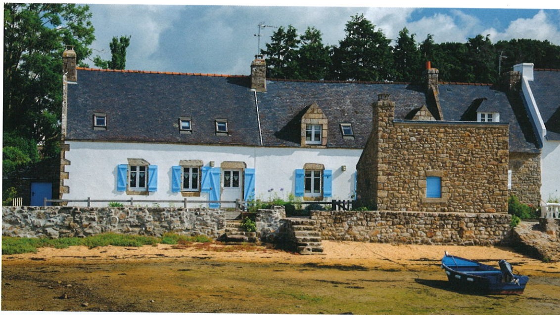
Une maison bretonne avec son toit d'ardoise face à l'océan à marée basse.
