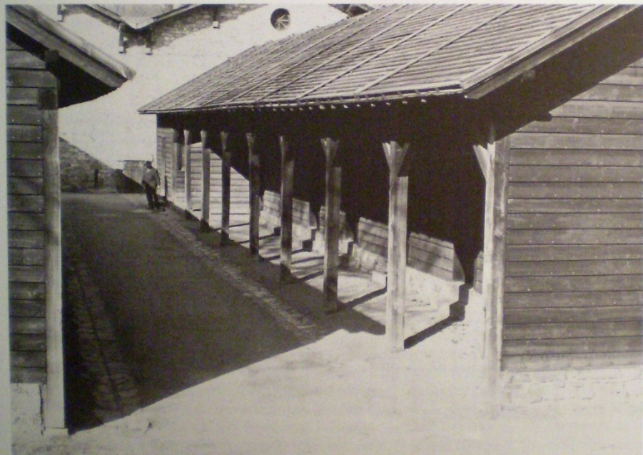
Abb. 128 Kastell Saalburg im Taunus (Hessen). Zwei rekonstruierte Mannschaftsbaracken (Centuriae), Holzbauten auf Steinfundamenten. Die Baracken sind nicht verputzt, sondern mit einer Bretterschalung versehen, nach Darstellungen auf der Trajanssäule. Bei der rechten Baracke ist das Vordach vor den Eingängen der Mannschaftsstuben deutlich zu erkennen. Am Ende dieser Baracke: vorspringender »Kopfbau« für den Centurio. Mit rund 35 m Länge gehören die rekonstruierten Baracken der Saalburg zu den kleinsten Bauwerken dieses Typs (Größe etwa wie in den Kastellen Hod Hill, Valkenburg, Hesselbach).
