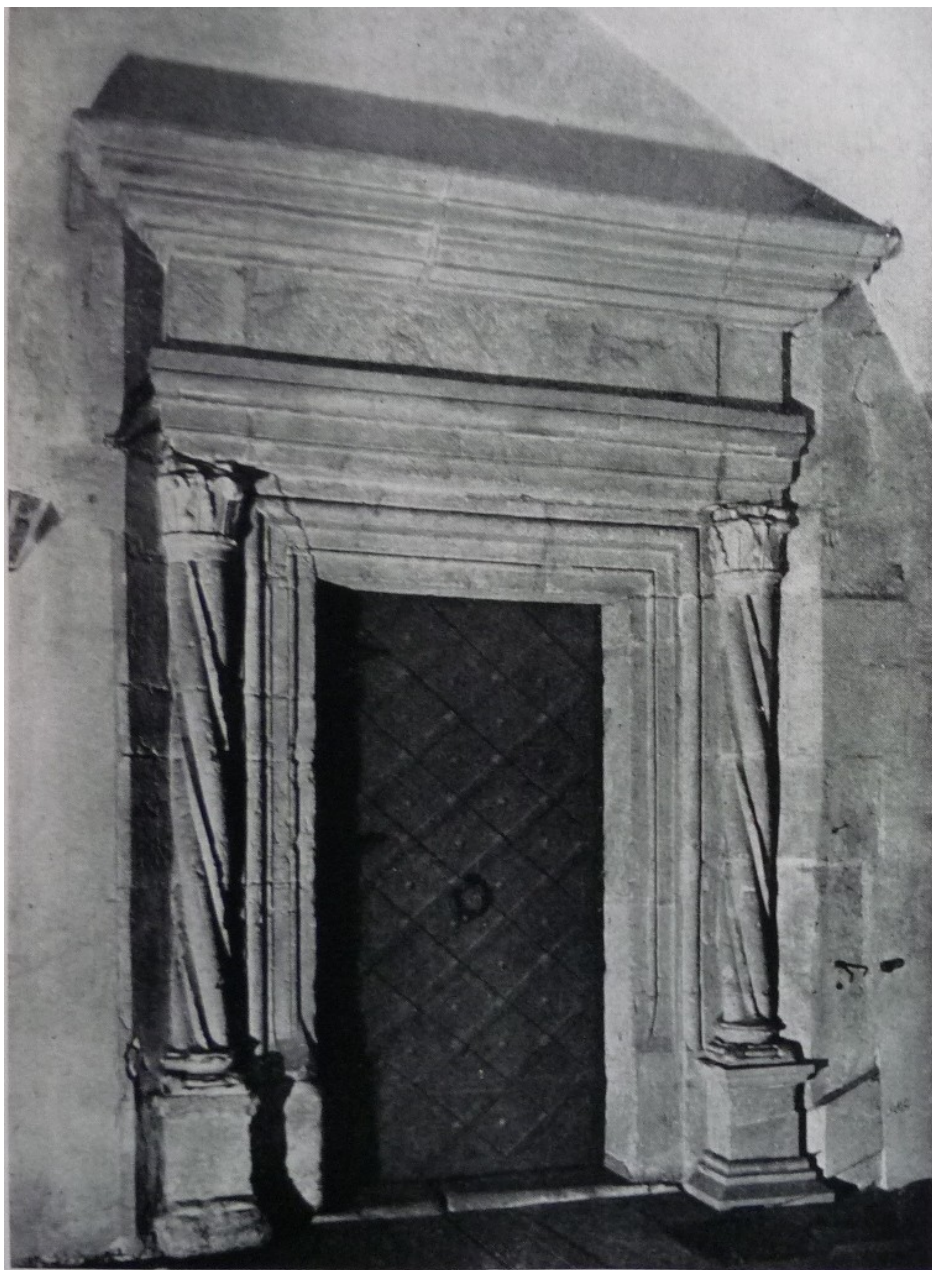
5. Praha, Hrad, Ludvíkovo křídlo, portál; před 1509
