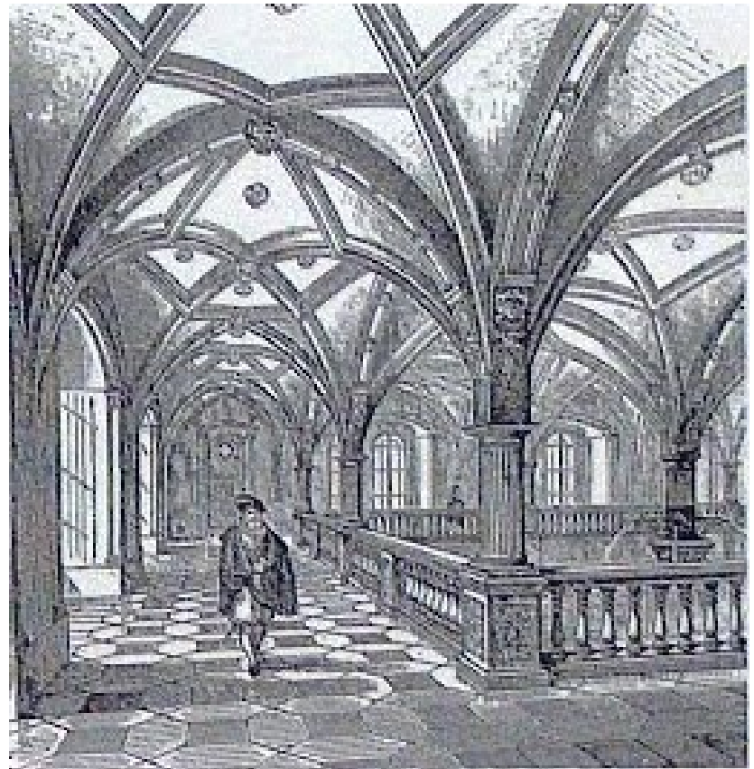
16. Stuttgart, Neues Lusthaus, Innenraum, ab 1584 (Ansicht um 1870)
