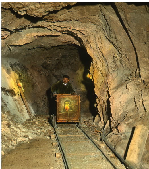
Obr. 86. (57-015) Vyvážení rubaniny z odvodňovací štoly r. 1928.
