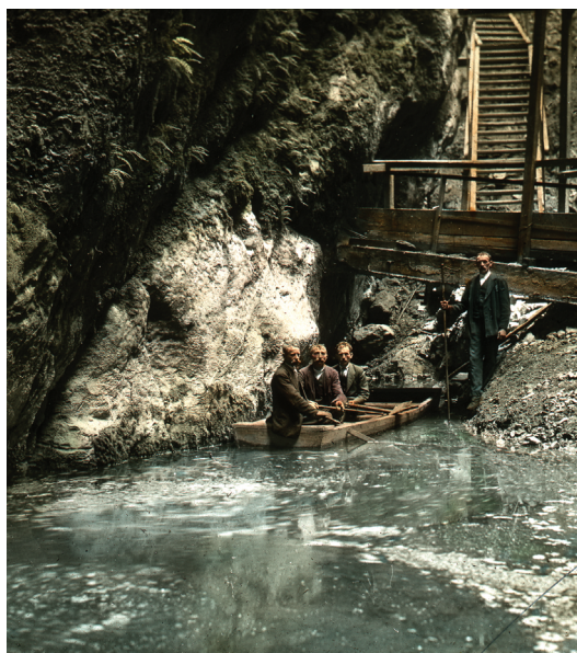
Obr. 85. (56-034) Můstek nad macošským jezírkiem.
