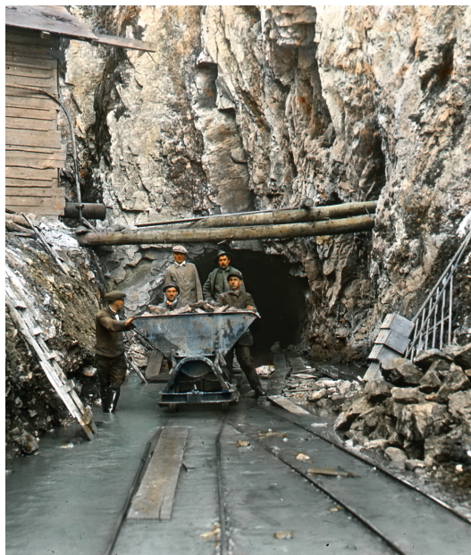
Obr. 93. (85-055) Ražení odvodňovací štoly z podzemní Punkvy do Pustého žlebu v letech 1928-1929.
