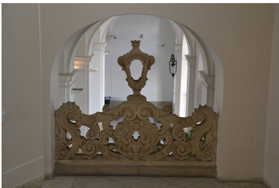
Obrázek 20: Zábradlí schodiště vedle vestibulu
