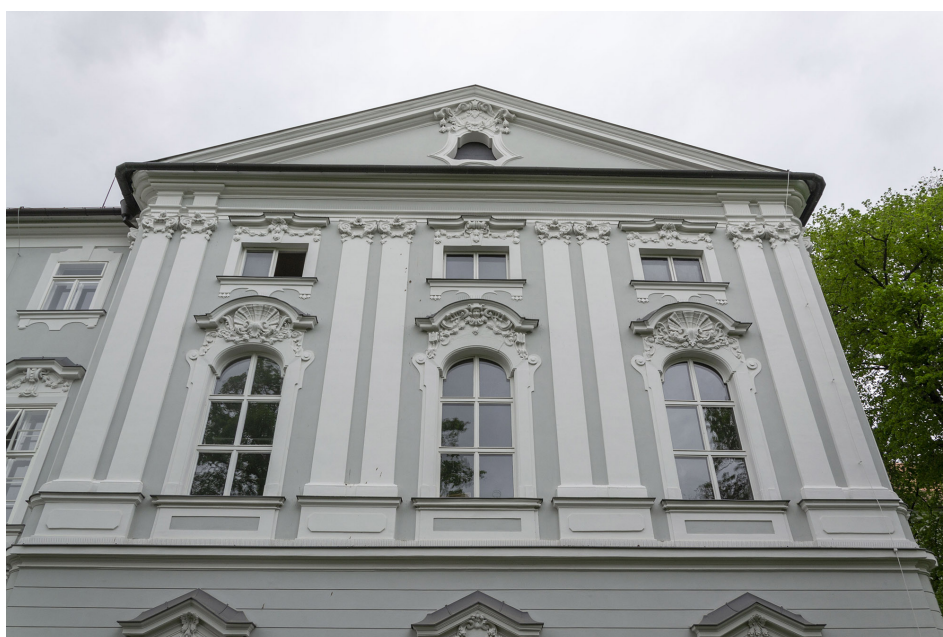
Obrázek 12: Rizalit u rohu ve styku prelatury a konventu
