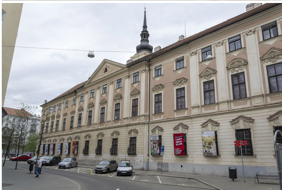
Obrázek 14: Fasády prefektury, západní a jižní
