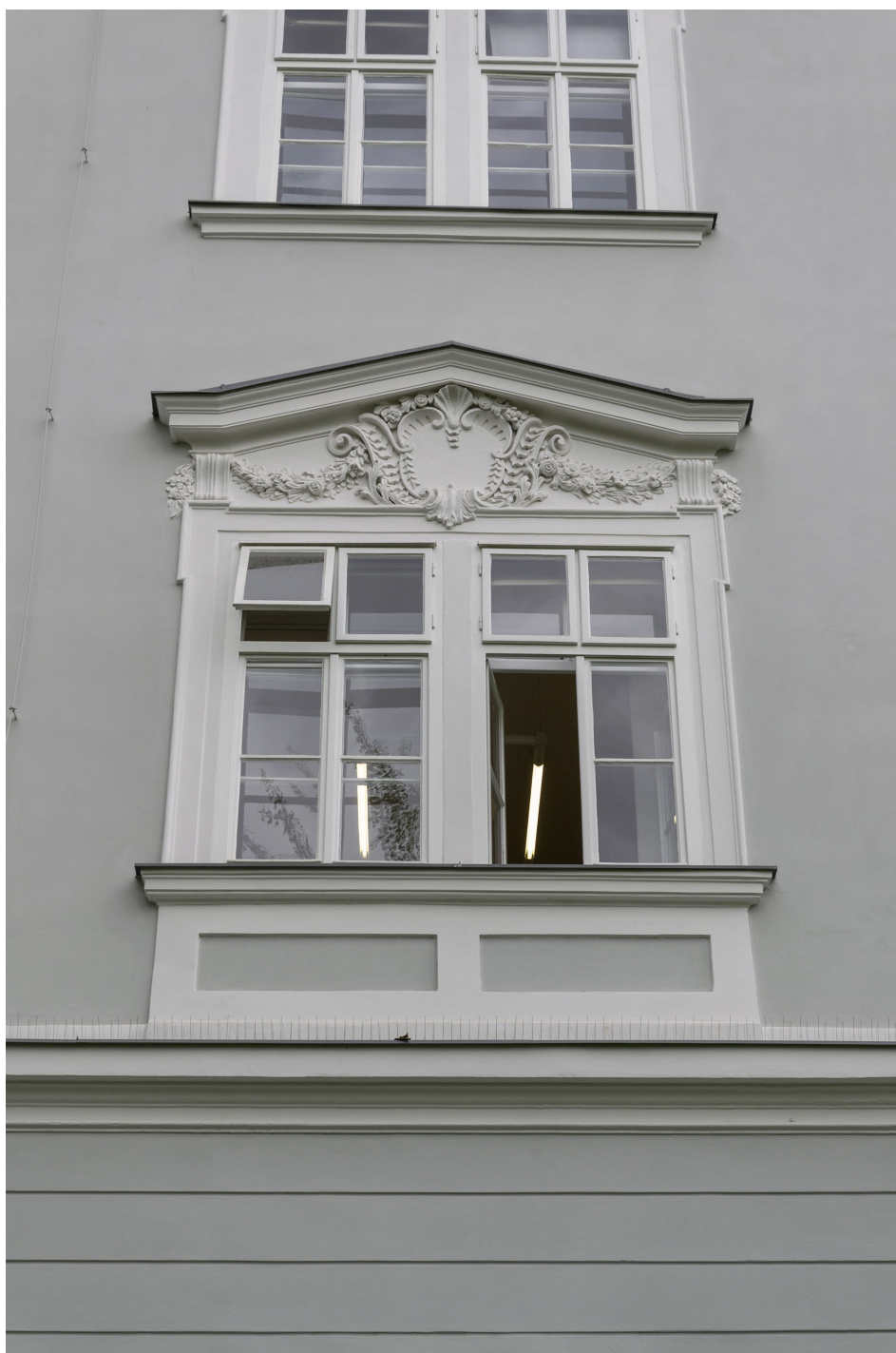
Obrázek 9: Zdvojené okno na fasádě konventu
