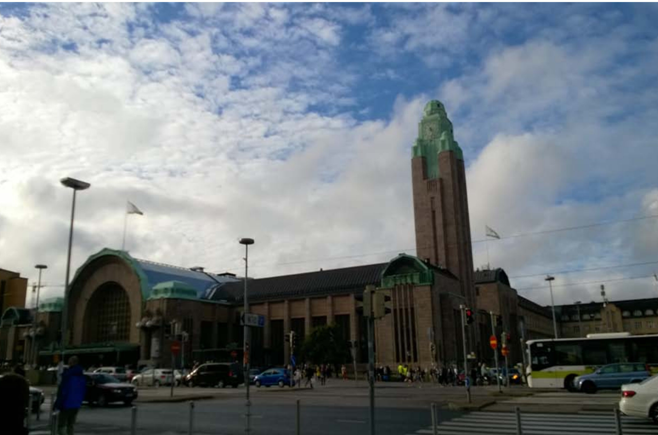
Budova hlavního nádraží v Helsinkách, Finsko (Eliel Saarinen, 1909-1919)
