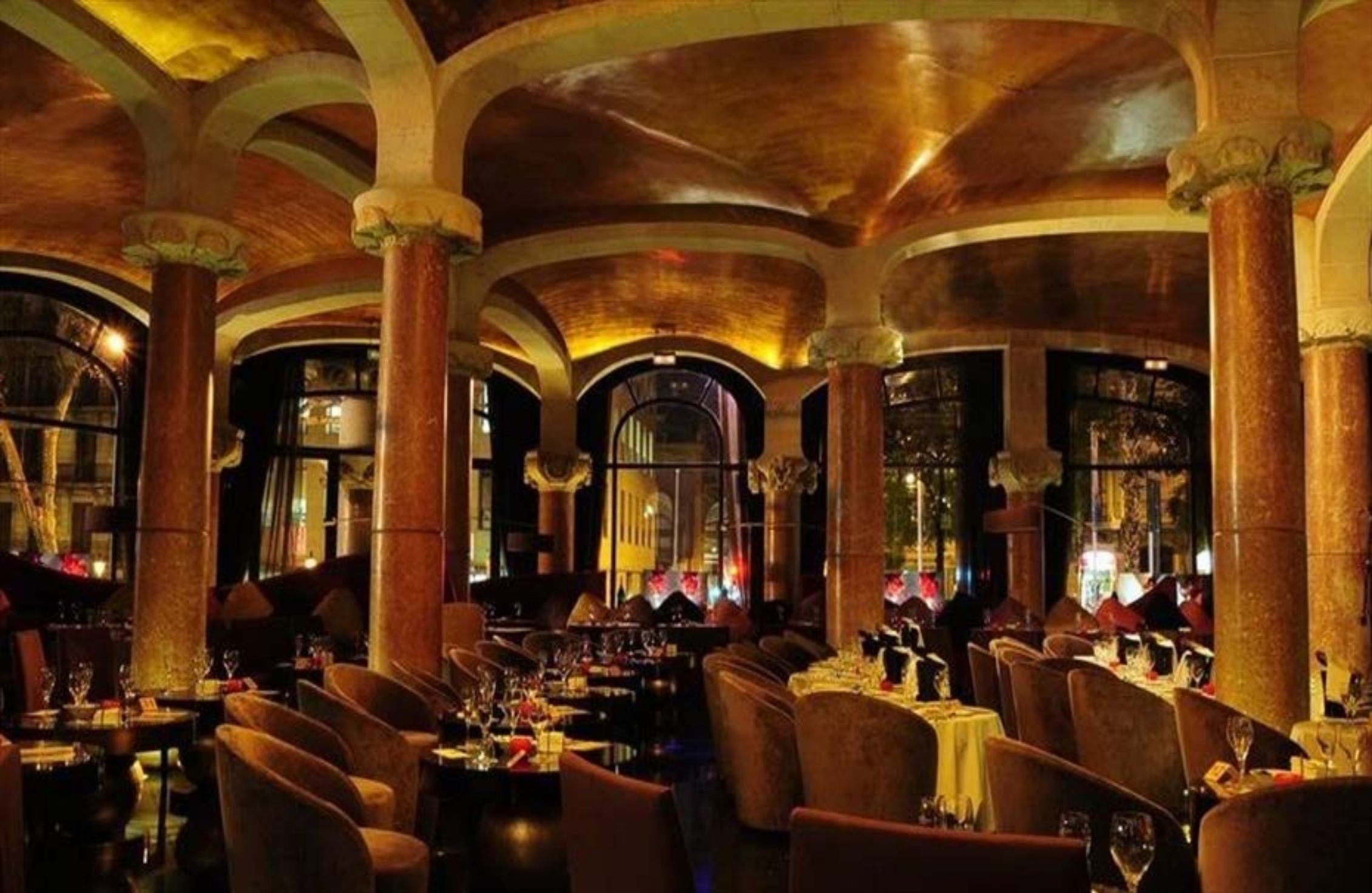
Casa Fuster (Barcelona, 1911): Domènechovo poslední dílo v Barceloně. Ve své době asi nejdražší barcelonská stavba ve své kategorii (kvůli materiálu – mnoho mramoru). Dlouhou dobu bytový dům s legendárním Cafè Vienès v přízemí. V 60. letech hrozba zbourání, nakonec zažehnáno. Od roku 2000 funguje jako luxusní hotel .
