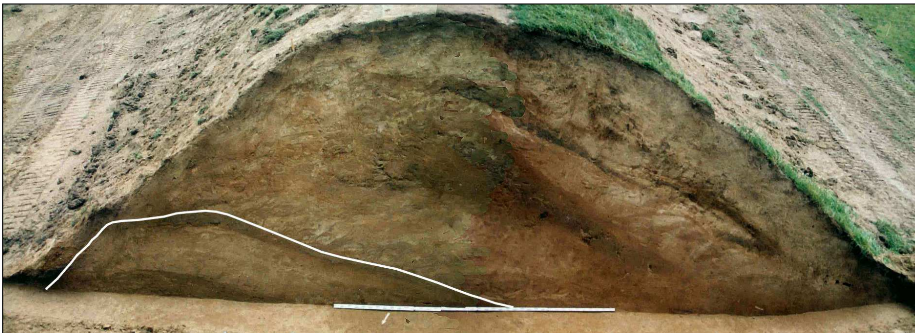
Řez protipovodňovou hrází na dolním Labi v Dolním Sasku, nejstarší jádro hráze je ze 13. stol. (výzkum Niedersächsisches Landesamt für Denkmalpflege 1997, foto P. Hrubý).
