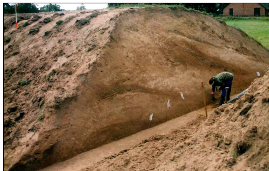
Řez protipovodňovou hrází na dolním Labi v Dolním Sasku, nejstarší jádro hráze je ze 13. stol. (výzkum Niedersächsisches Landesamt für Denkmalpflege 1997, foto P. Hrubý).
