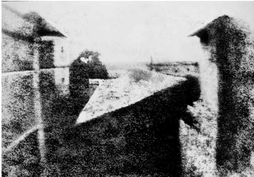
Nicéphore Niépce: Pohled z okna v Le Gras, 1826
