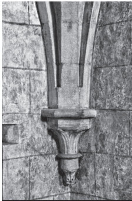
387. Zdvojenou konzolu klenuté místnosti v prvním patře věže Staré radnice pravděpodobně zhotovil kameník podílející se předtím na stavbě kláštera cisterciáček Porta coeli v Tišnově (dnes Předklášteří).
