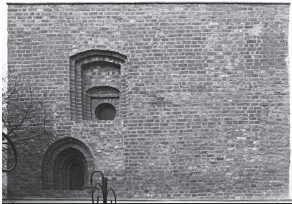
386. Zed' přístavku Staré radnice z režného zdiva s okénky (kolem roku 1500 s možností poněkud staršího datování).
