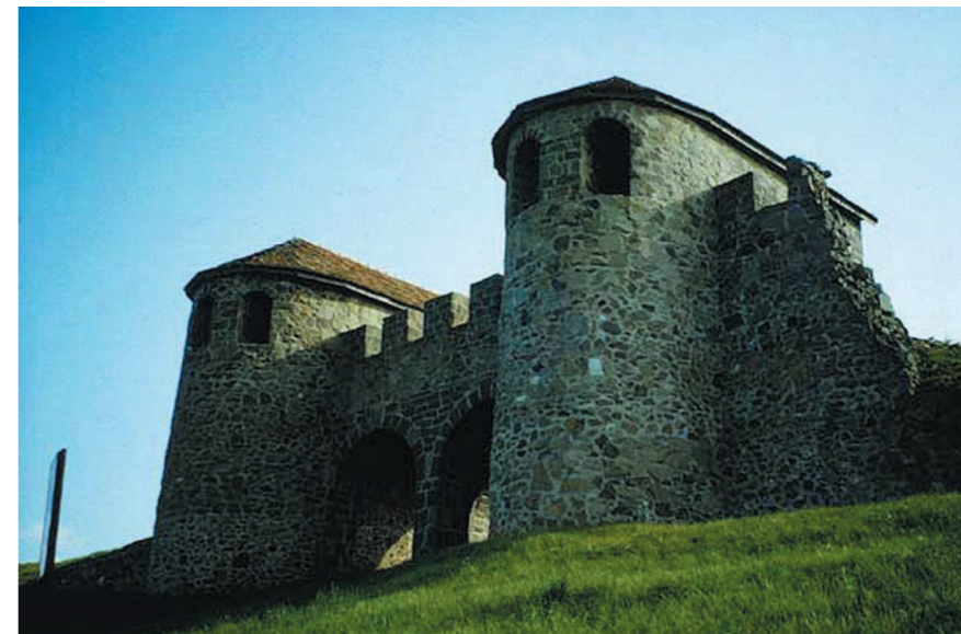
55. The reconstructed north gate of the fort at Porolissum (Romania) 55. Rekonstruisana severna kapija utvrđenja u Porolisumu (Rumunija)
