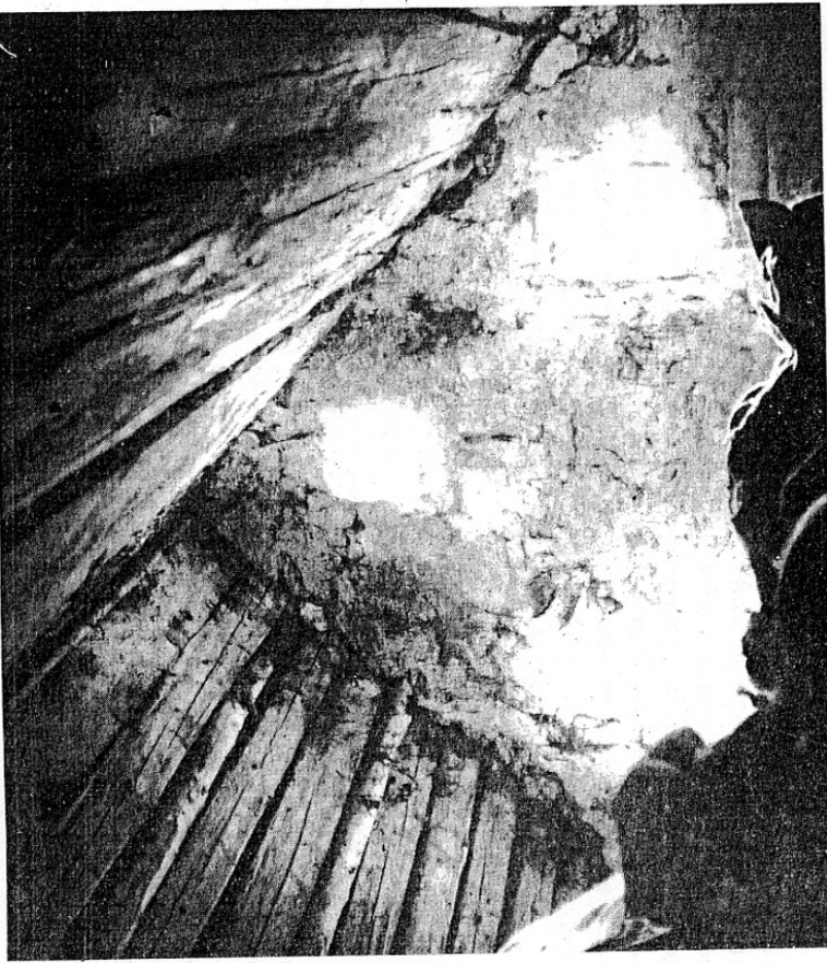
Svojišice u Sušice čp.15, vnitřek horní komory v sýpce, zabezpečené dřevohliněnou izolační konstrukcí s trámkami, uloženými na ústupky zdíva štítů. V čelní stěně je trojice otvorů systému 2-1, s horním otvorem kruhovým (pohled na sýpku z návsi je vpravo dole). Vlevo dole je štítová stěna zděné sýpky z Čechelovic se sestavou štěrbinových průduchů, nejtypičtější pro oblast Horažďovicka
