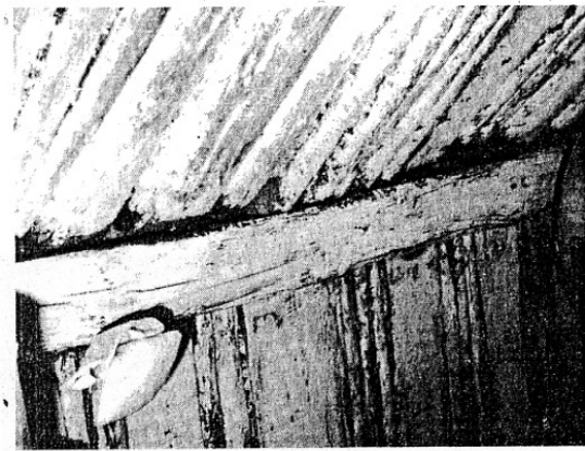
Nejobvyklejší skladba bednění pod hliněnou izolací lepence je zachycena na snímku ze sýpky ve Švejcarově Lhotě u Strakoníc
