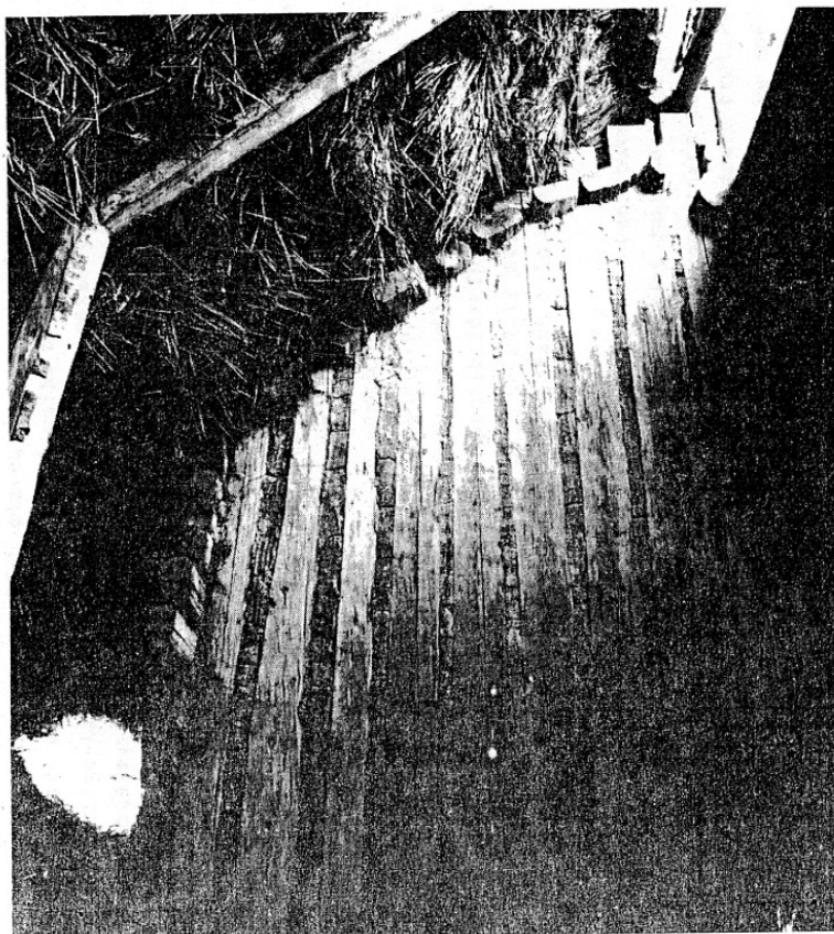
Roubená poloklenba horní, podkrovní komory v hospodářské budově, sdružující sýpku a kolnu. Sedmpány u Vlašimi čp.7
