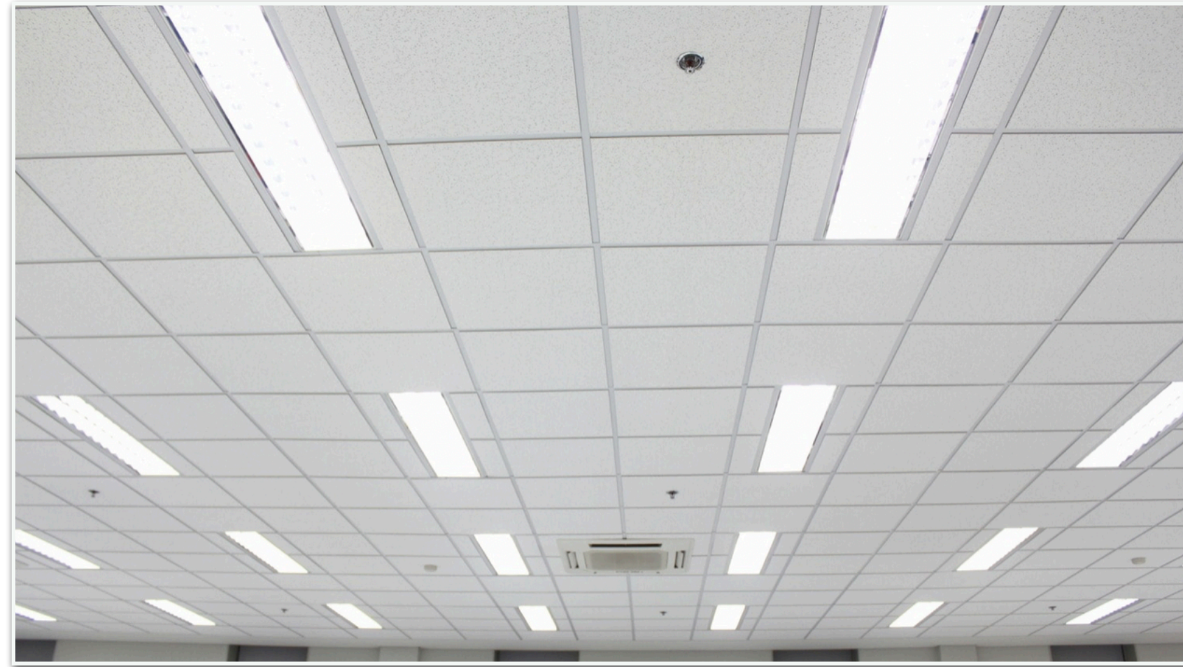
Celistvý stropní podhled
