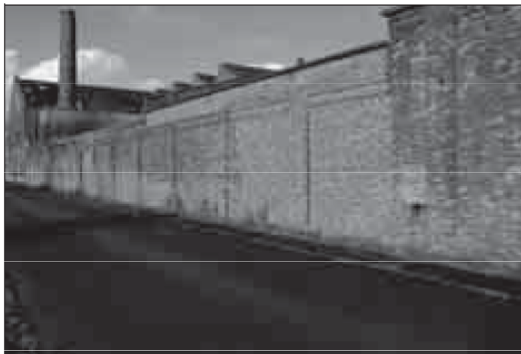
De lange muur van de Kapellekensbaan in Erembodegem.
