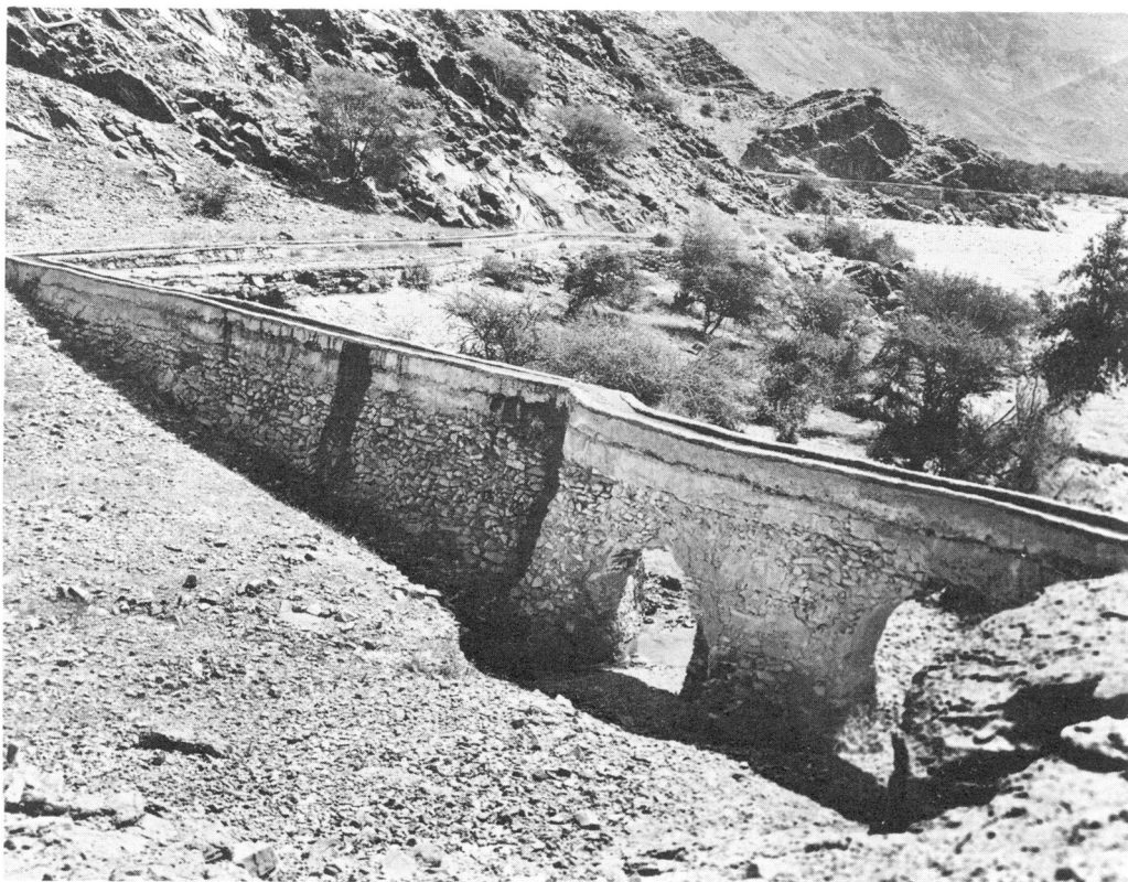
Plate 4 Aqueduct in Wadi al-Sirrayn.
