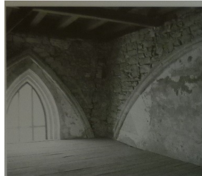
Přístěnná žebra pro uložení bednění západního pole klenby nad lodí bývalého kostela sv. Anny kláštera dominikánek na Starém Městě v Praze z 1. poloviny 14. století. Obdélná klenební pole měla stejnou výšku čelních oblouků, z nichž kratší byly hrotité.
