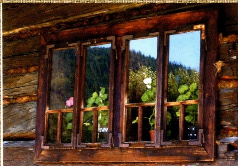
▲ Okno zrubového domu
