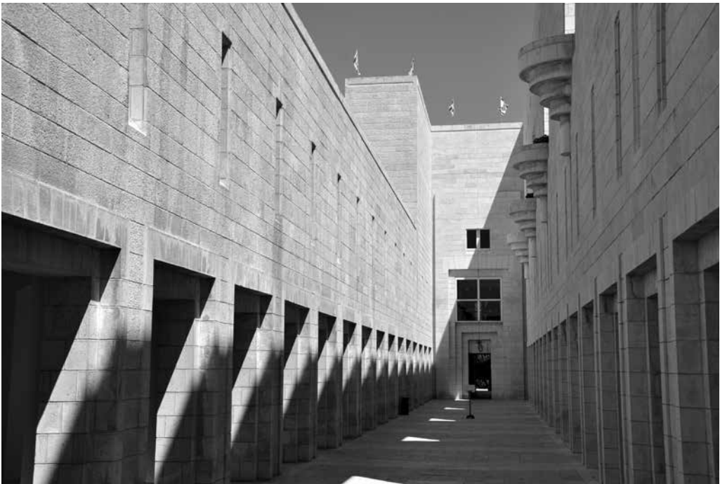
Fot. 8. Sąd Najwyższy w Jerozolimie (arch. Ada Karmi-Melamede Architects & Ram Karmi, 2012), fot. autor
