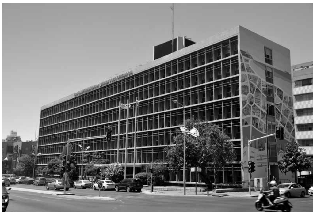
Fot. 6. Siedziba Światowej Organizacji Syjonistycznej w Tel Awiwie (arch. Arie Sharon i Benjamin Idelson, 1957), fot. autor
