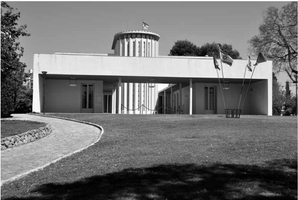
Fot. 4. Rezydencja Weizmana w Rehovot, widok od północy (arch. Erich Mendelsohn, 1934-36), fot. autor
