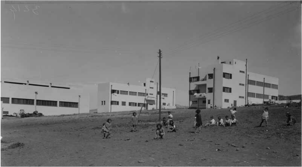
Fot. 3. Świetlica, szkoła i dom dziecka w kibucu Ein Harod (arch. Richard Kauffman, ok. 1930), fot. American Colony Photo Dept., 1920-1933, Matson Photograph Collection, US Library of Congress, LC-M32-3214
